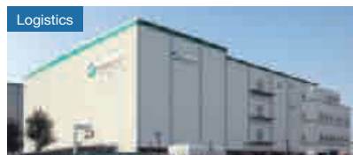
D Project Kita Hachioji Annex B
