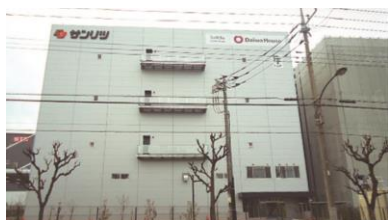
D Project Kita Hachioji Annex A
