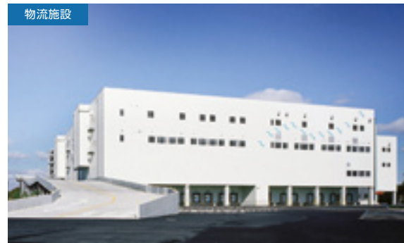
物流施設 L-B-2 Dプロジェクト八王子
