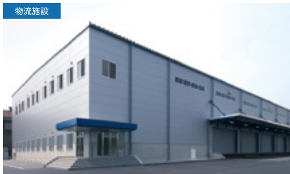
物流施設 L-B-3 Dプロジェクト愛川町
