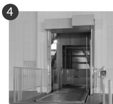
4 垂直搬送機 効率的な荷物搬送を行う ための十分な基数
