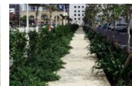
外構緑化・透水性舗装
