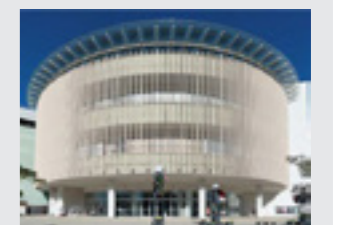
太陽光発電設備
