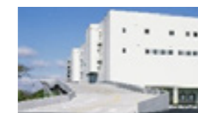
上層階へのスロープ設置
