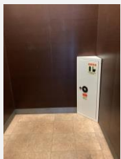
(カスティア薬院のエレベーター内設置の非常用品収納BOX)
