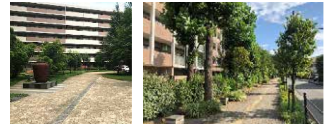
透水性インターロッキングの採用
