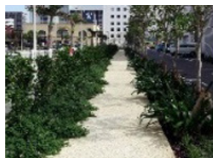
外構緑化・透水性舗装
